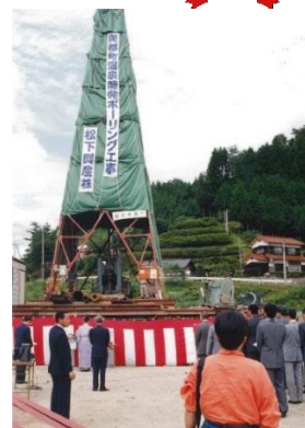
H2年 ボーリング工事完了時
