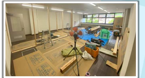
改修工事の様子
